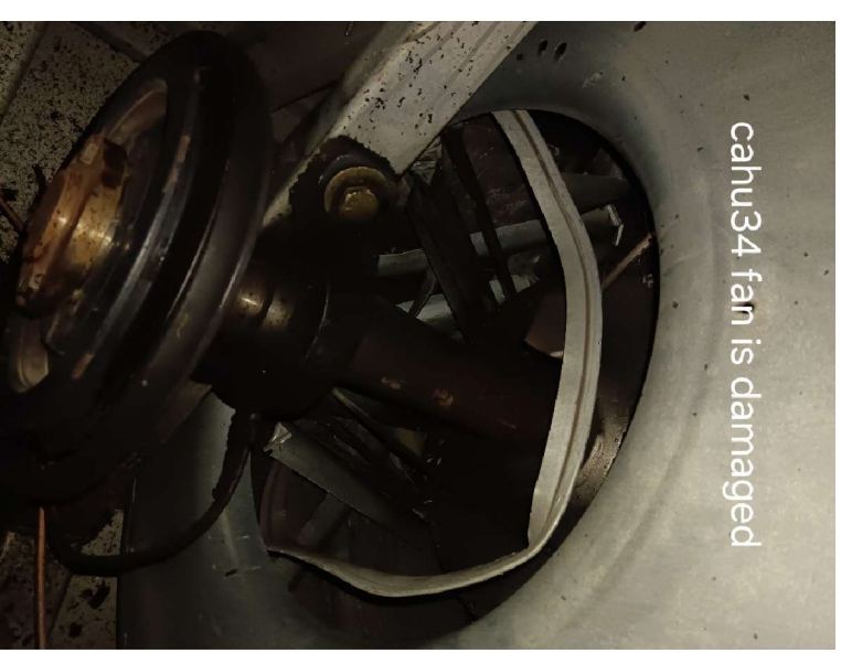
Fan Failures
